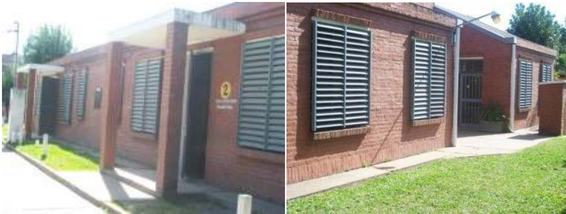
-Salas Velatorias Públicas Municipales. Fachada y contrafachada.
