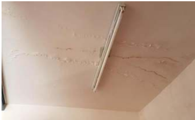
Se observa una humedad que proviene de la losa técnica existente, perjudica las paredes y el cielorraso. Ambas Salas.
