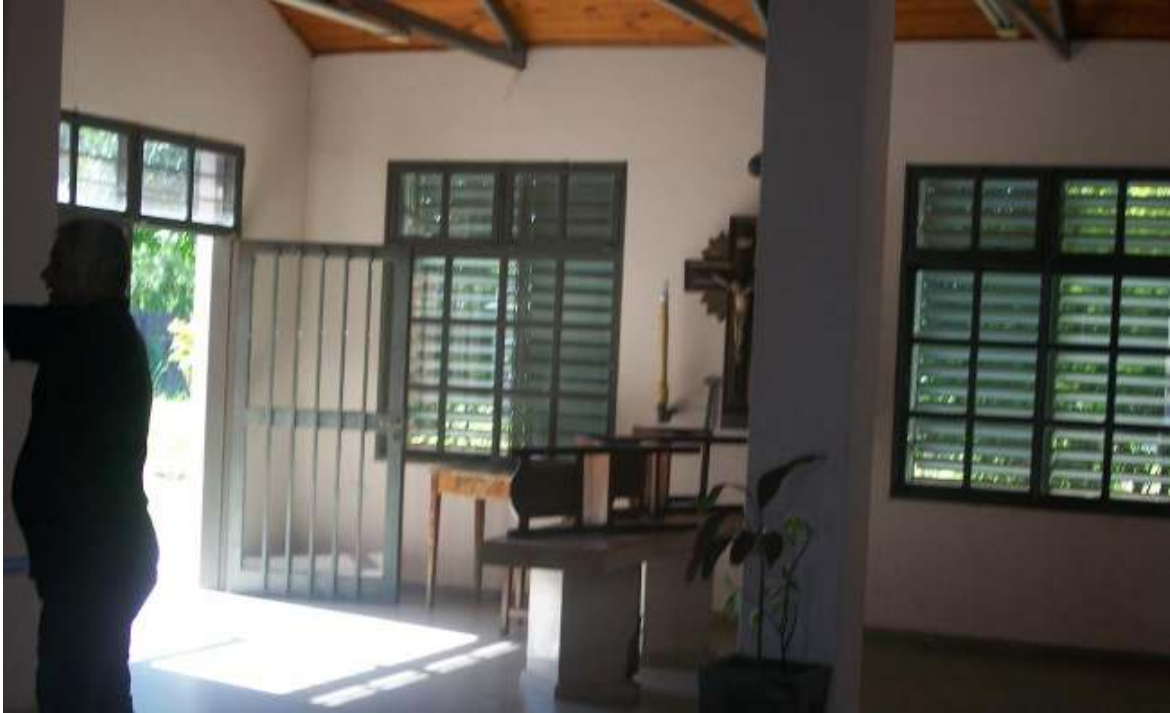
Dentro de las Salas Velatorias, el estado es prolijo en general. Presentando cuestiones de mantenimiento. Se observa una placa de marmol rota en la base del pedestal funebre.
