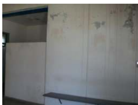
Se observa una humedad que proviene de la losa técnica existente, perjudica las paredes y el cielorraso. Ambas Salas.
