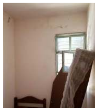
Se observa una humedad que proviene de la losa técnica existente, perjudica las paredes y el cielorraso. Ambas Salas.
