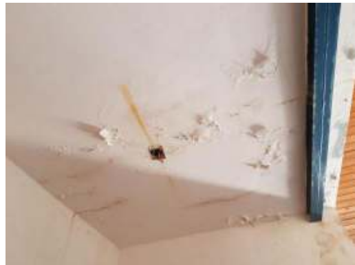
Se observa una humedad que proviene de la losa técnica existente, perjudica las paredes y el cielorraso. Ambas Salas.
